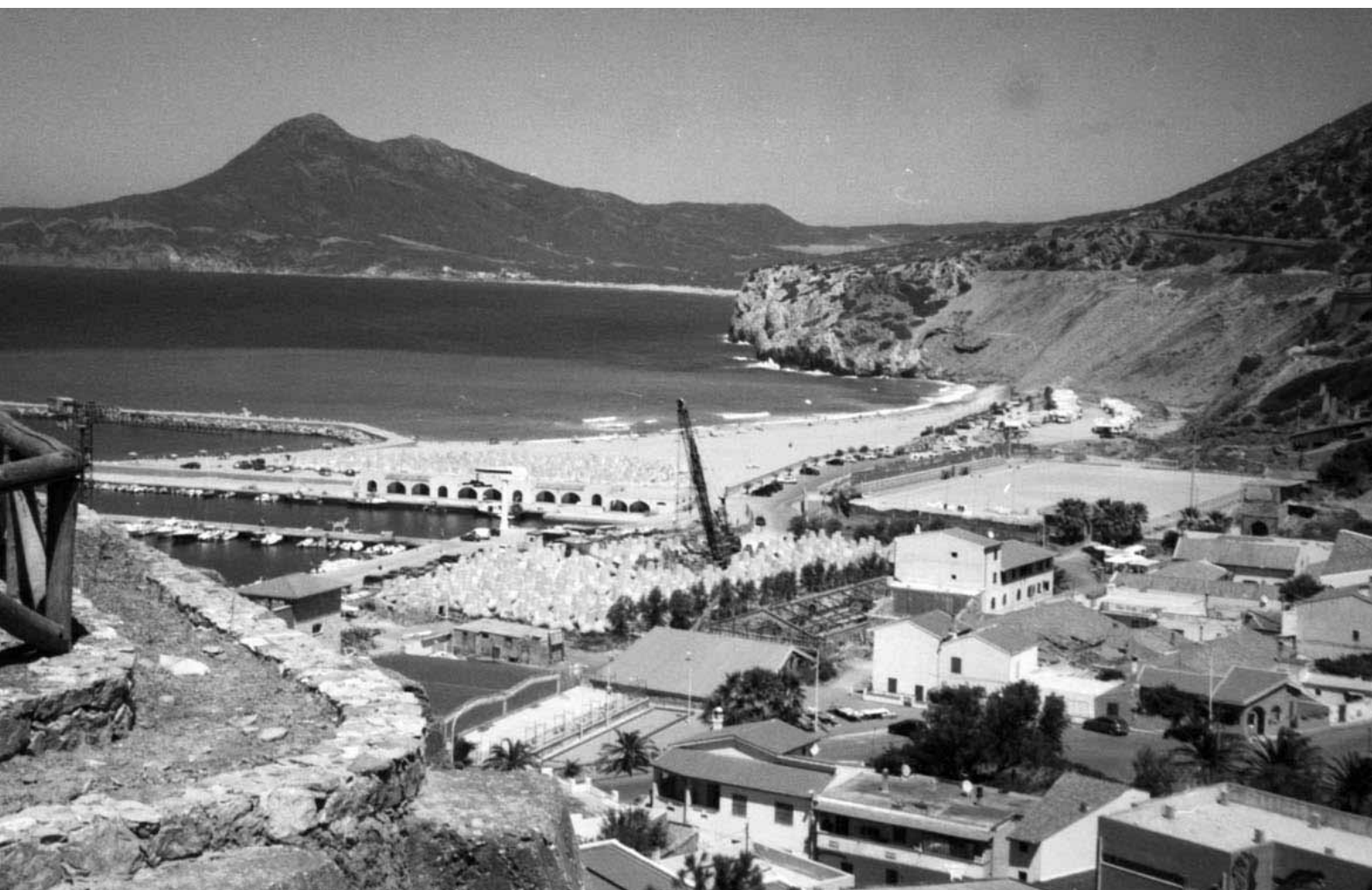
Veduta di Buggerru dall'ingresso della galleria
