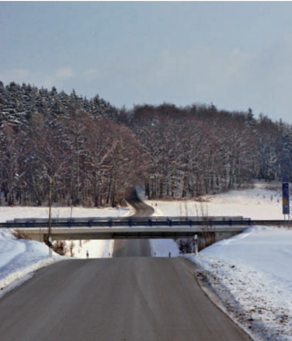
Il percorso dell'antica via romana ad est di Gilching, ancora in uso, si abbassa in un sottopassaggio per non interferire con il tratto della nuova strada provinciale.
